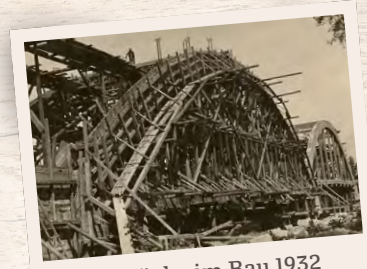
Bogenbrücke im Bau 1932
